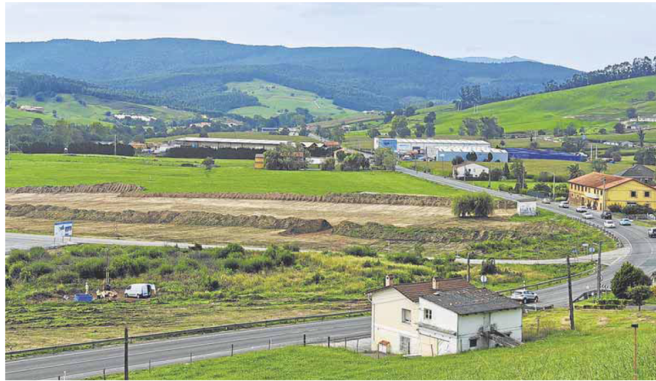
Imagen de las obras del llano de La Pasiega, tras los primeros movimientos de tierra el pasado mes de septiembre. DANIEL PEDRIZA
