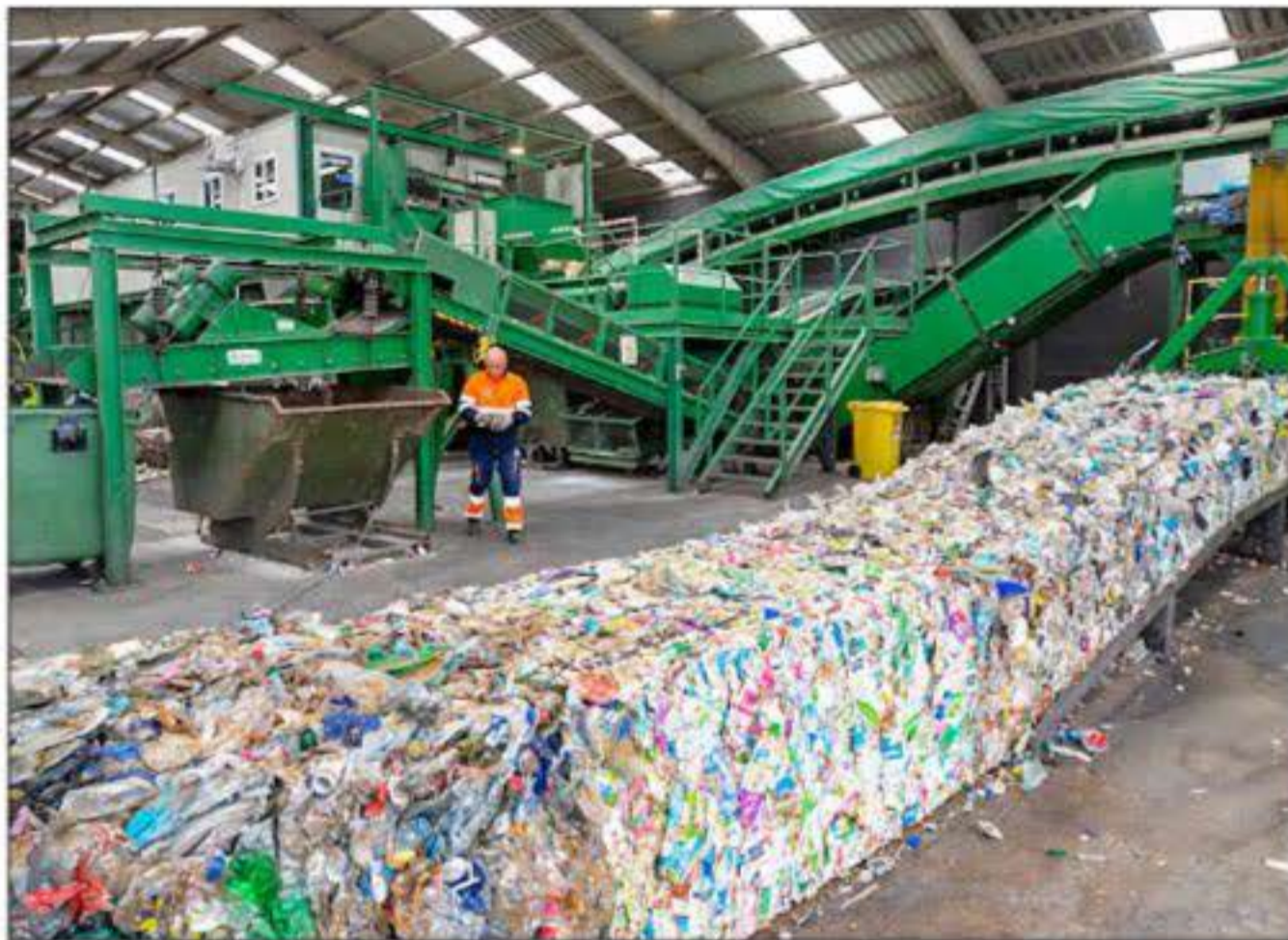
El proyecto duplicará la capacidad de tratamiento de envases ligeros, alcanzando 4 toneladas por hora. / ALERTA
